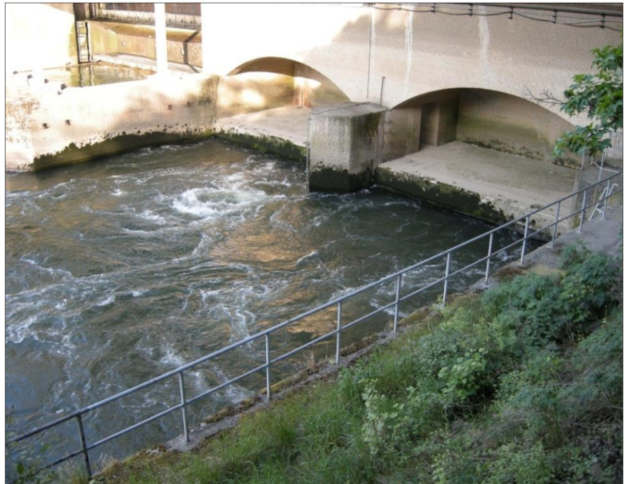
Abb. 4.3: Strömungsbild unterhalb der Saugschläuche. Die stärksten Turbulenzen treten jeweils im linken Bereich hinter den Saugschläuchen auf
