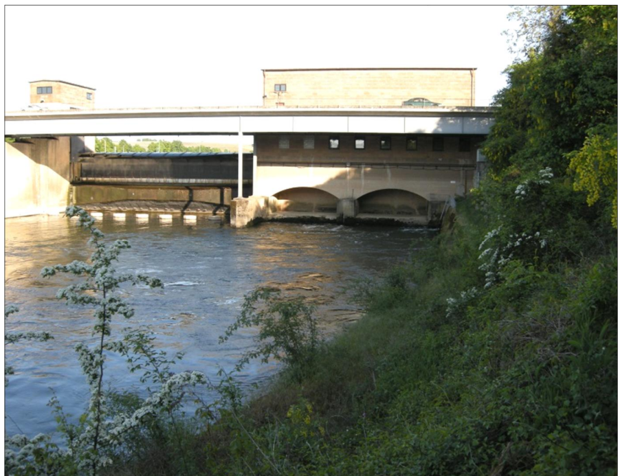
Abb. 4.1: Wasserkraftanlage Lauffen und angrenzendes Wehrfeld, Blick von Unterwasser
